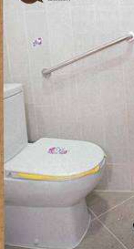
拆牆磚、地台，重新設計洗手盆及廁所設計，在牆上安裝合適的扶手及安裝扶手。
